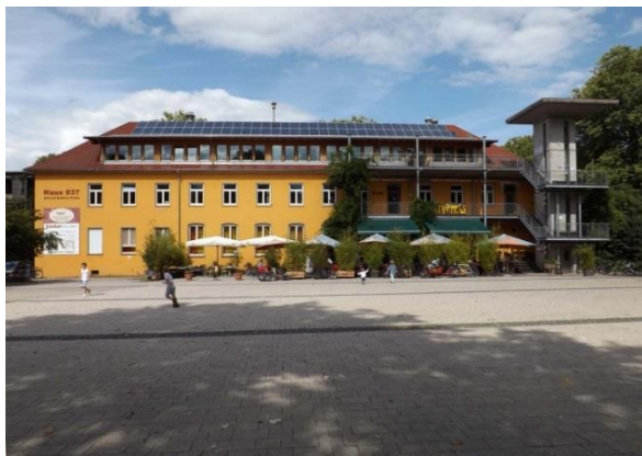
住宅地の核となっている建物
